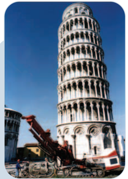
Installazione tiranti lato sud
