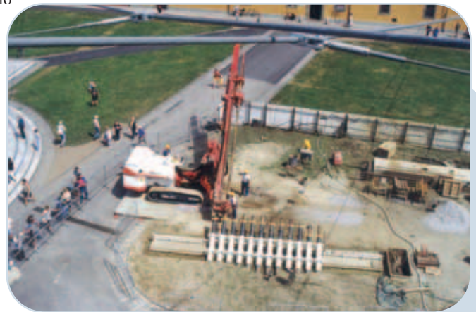
Sottoescavazione preliminare
